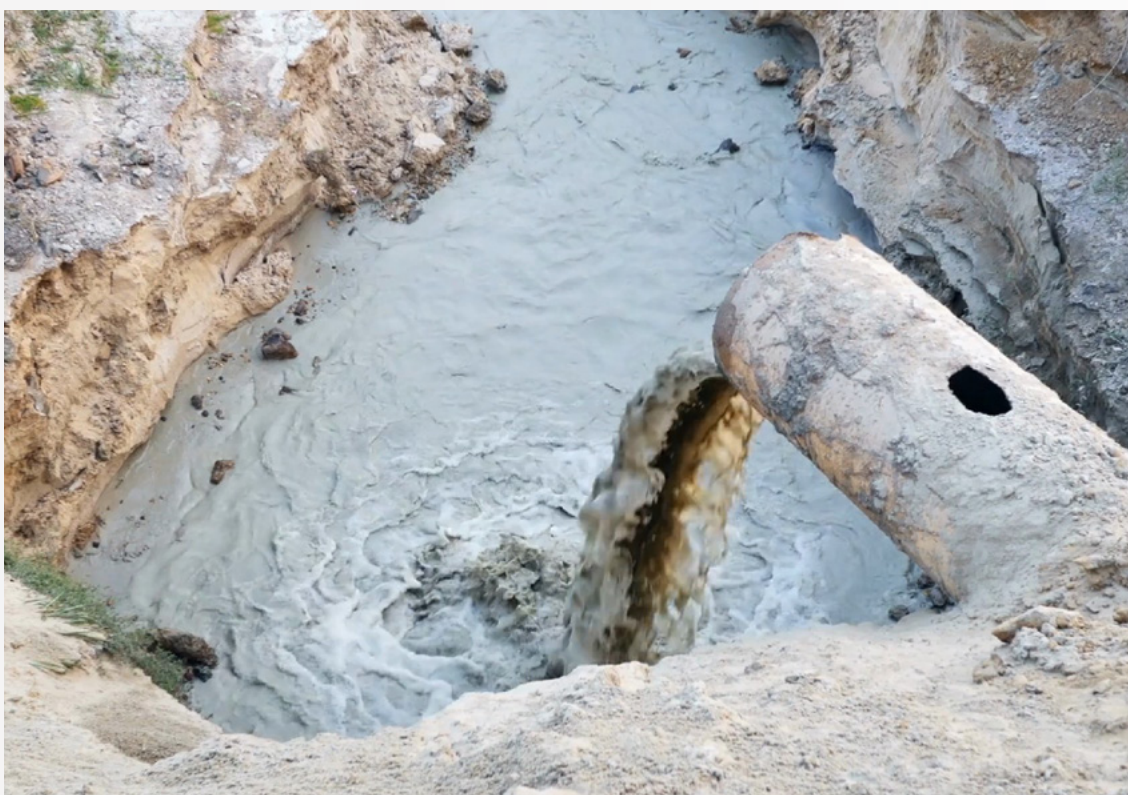
IMAGEN 11. Vertido de aguas residuales sin depurar. Fuente: fondo documental del Organismo.
